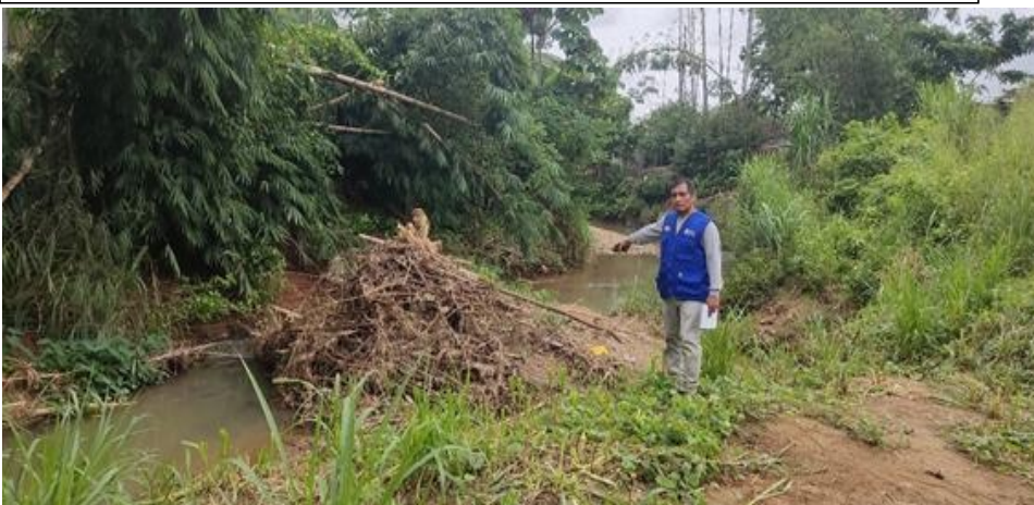
FIGURA N°02: RIO SUPTE CHICO, SE OBSERVA LA SECCIÓN HIDRAULICA DISMINUIDA POR LA
